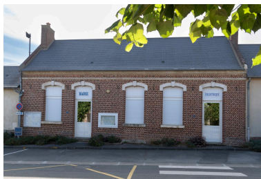
Mairie-école, vue depuis le nord-ouest. Phot. Marc Kérignard IVR32_20226000858NUCA
