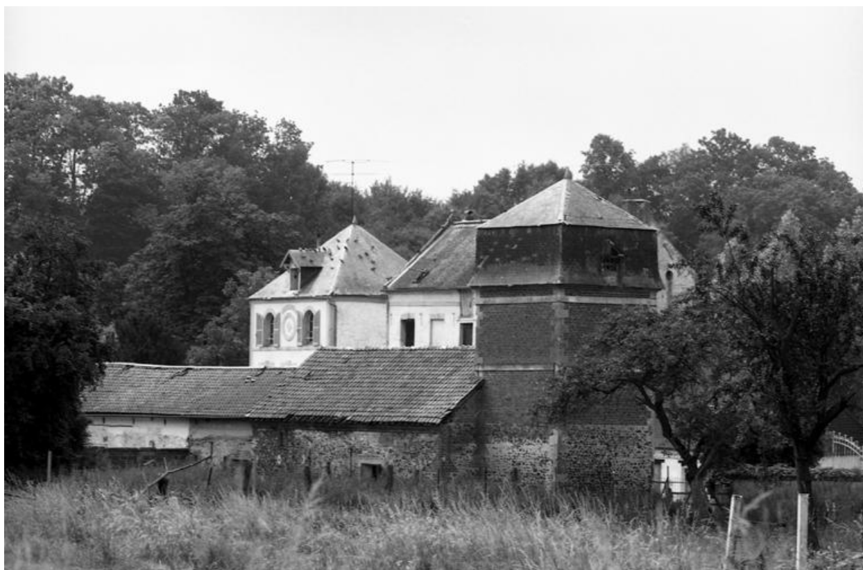
Vue d'ensemble des bâtiments, depuis le nord.
