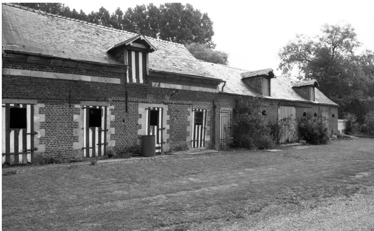
Vue de l'élévation sur cour des étables.
