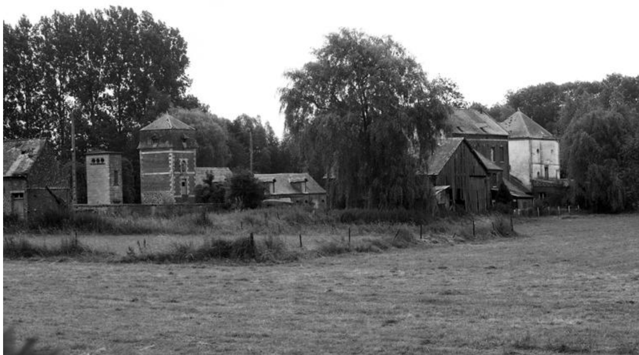
Vue d'ensemble des bâtiments, depuis l'ouest.
