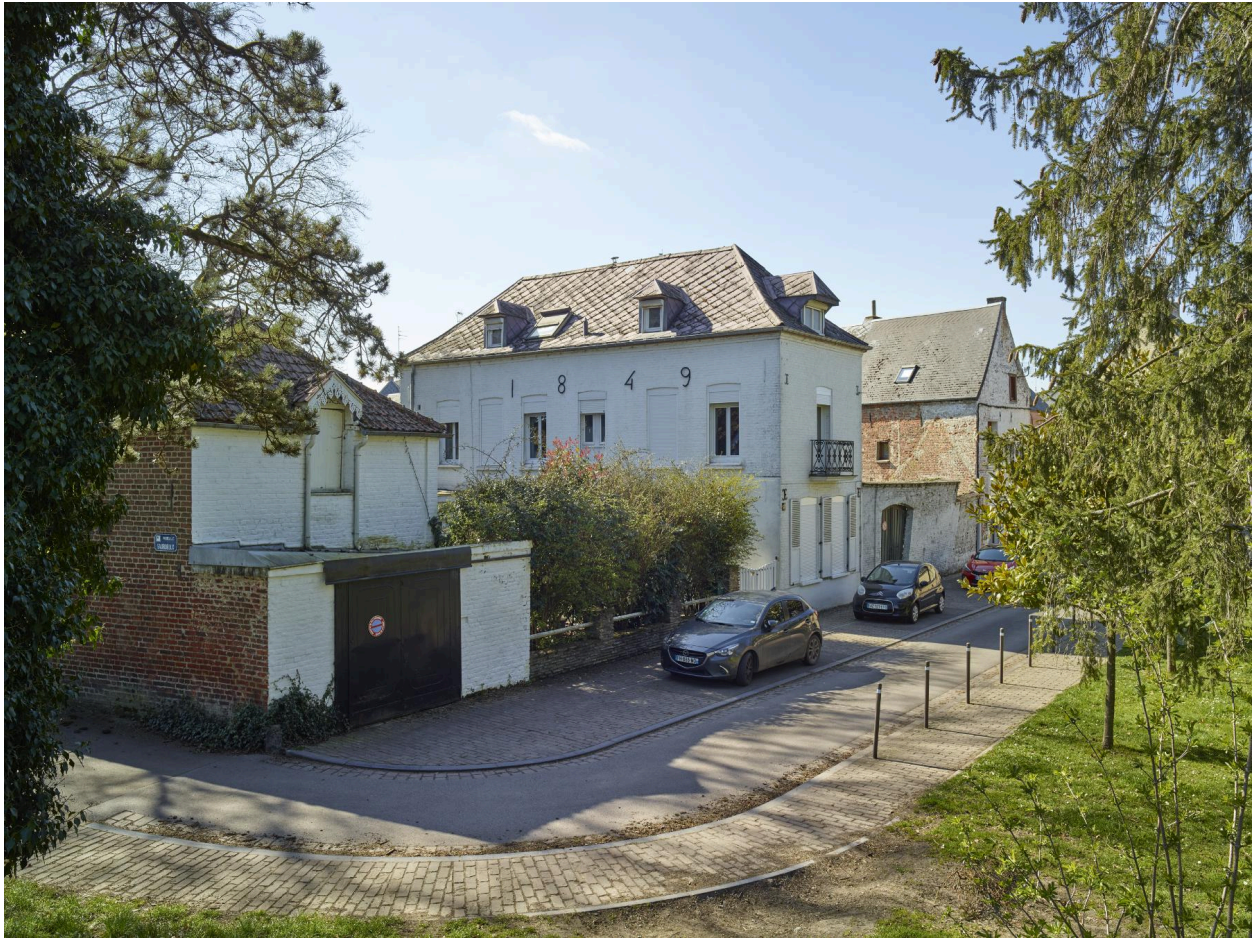
Maison : vue générale depuis la place du Casse-Tête. Vue orientée sud-est/nord-ouest.
