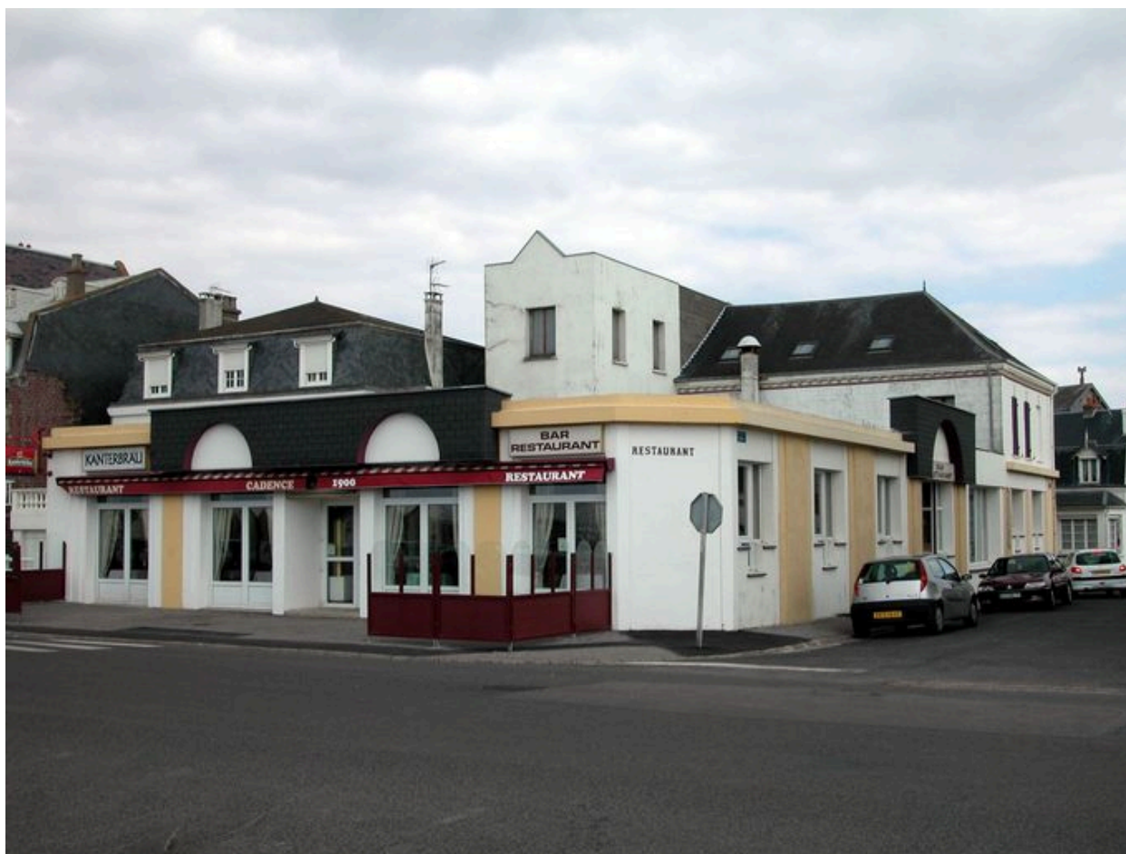
Vue d'ensemble depuis le front de mer.
