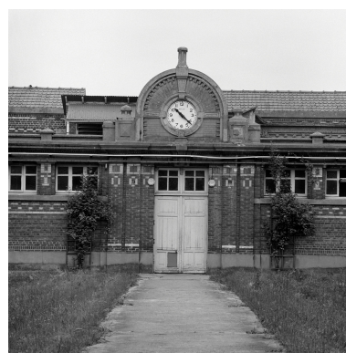
Elévation sud, détail. Phot. Philippe Dapvril IVR31_19885900820X
