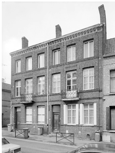
Vue générale des deux maisons (état en 2000).
