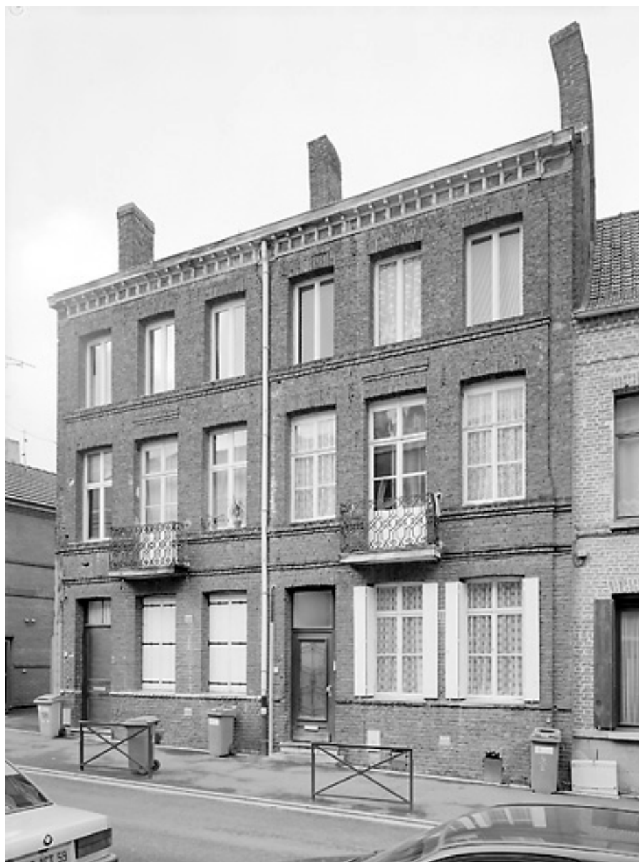
Vue générale des deux maisons (état en 2000).
