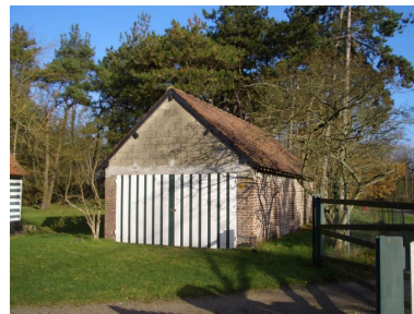
Vue du garage. Phot. Inès Guérin IVR22_20078005072NUCA
