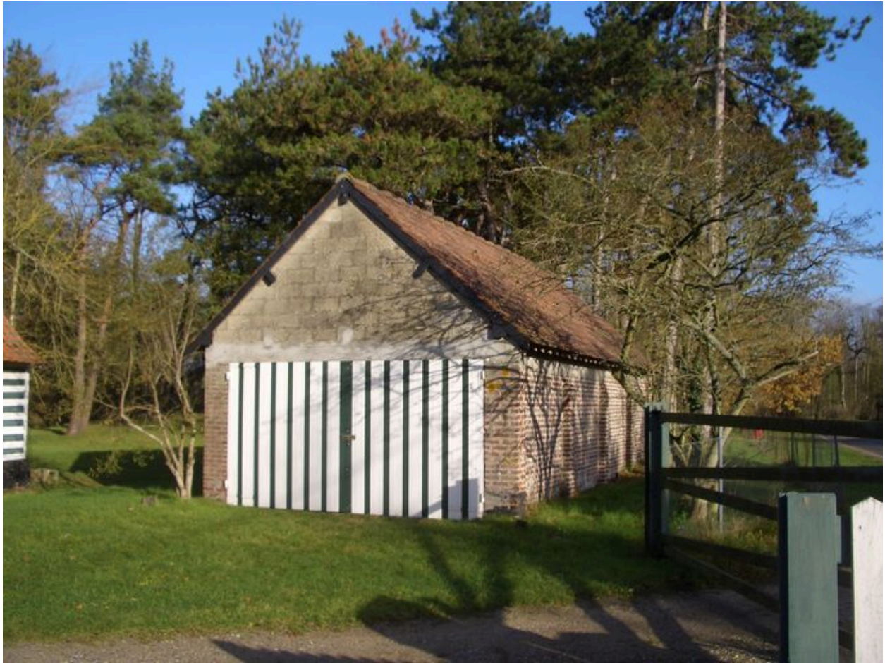
Vue du garage.
