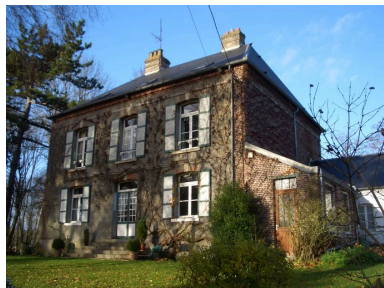
Vue générale de la maison. Phot. Inès Guérin IVR22_20078005070NUCA
