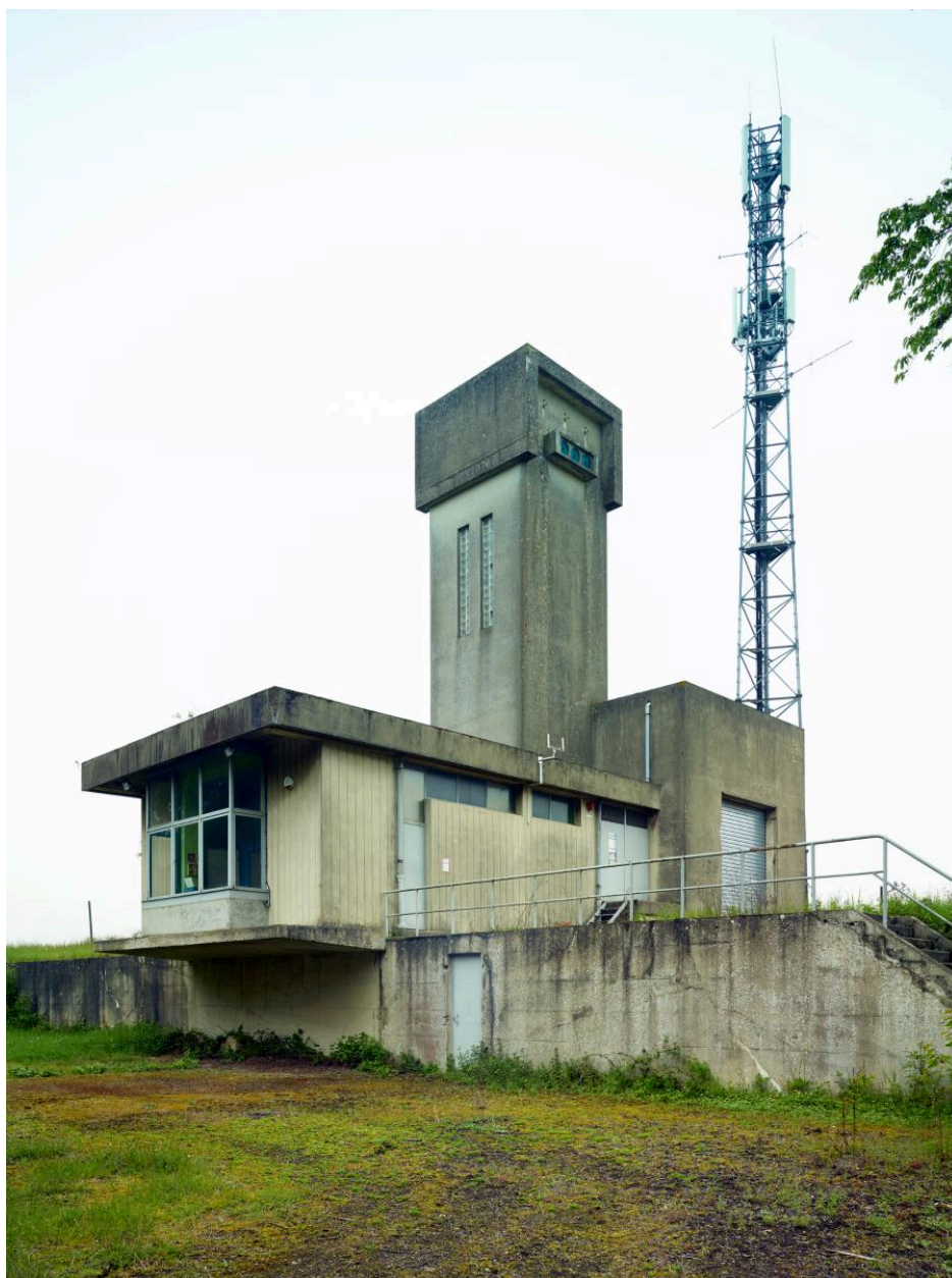
Façade du poste de commande. Vue depuis le sud-ouest.
