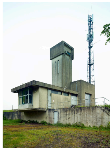
Façade du poste de commande. Vue depuis le sud-ouest. Phot. Pierre Thibaut IVR32_20216200764NUC4
