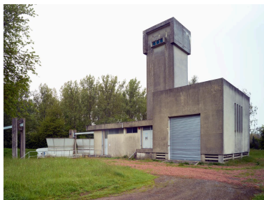
Poste de commande, façade sud. Vue depuis le sud-est. Phot. Pierre Thibaut IVR32_20216200761NUC4
