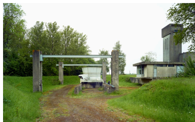
Poste de commande et turbines de ventilation. Vue depuis le sud-ouest. Phot. Pierre Thibaut IVR32_20216200796NUC4
