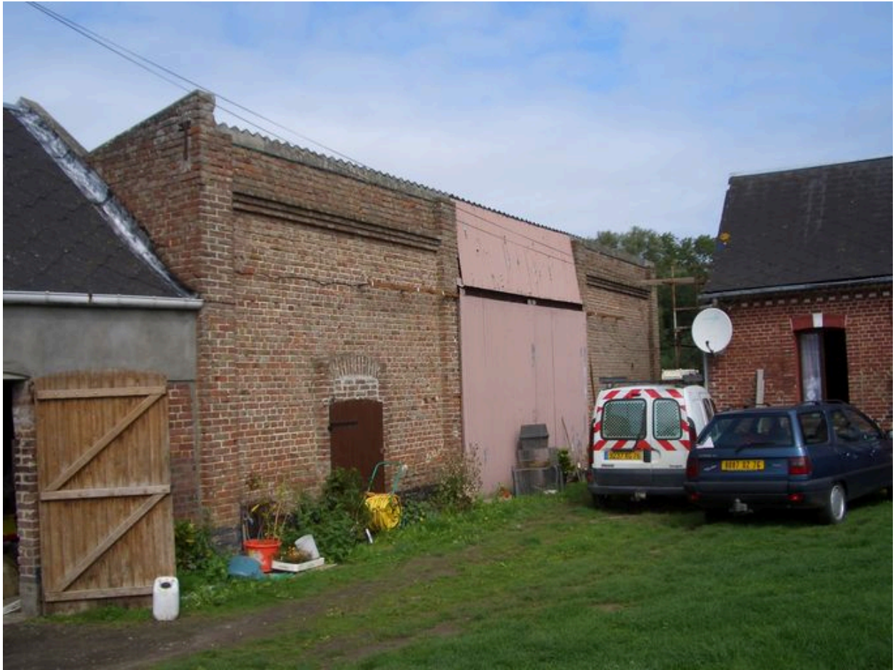
Vue de la grange.
