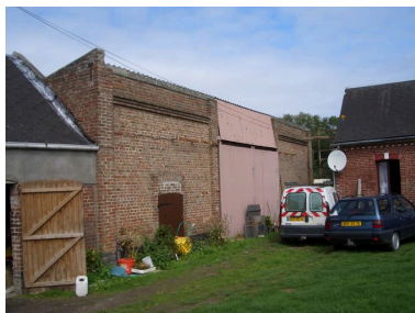
Vue de la grange. Phot. Inès Guérin IVR22_20078005160NUCA
