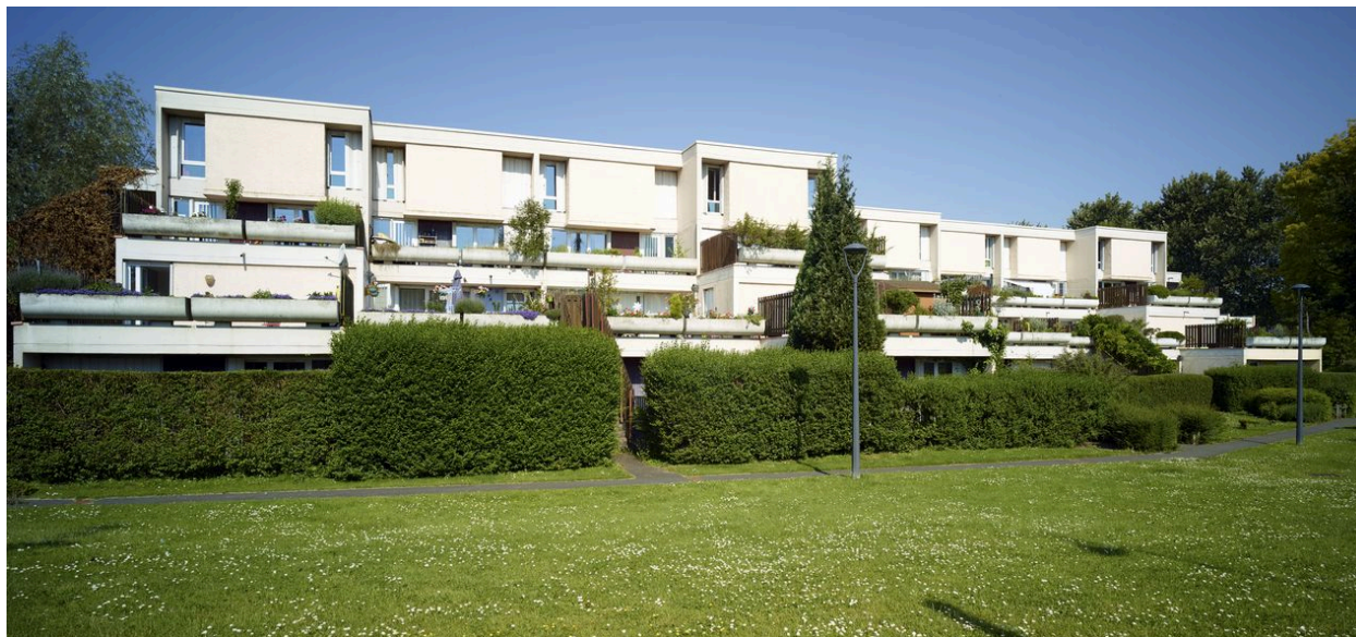
La façade en gradins des immeubles n° 50 à n°54, depuis le Chemin des Chaumières qui traverse l'îlot.
