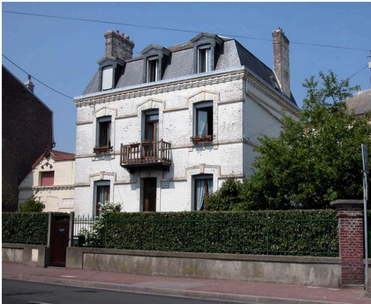
Vue d'ensemble depuis la rue.
