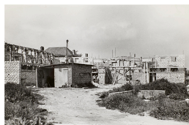
Reconstruction de la ferme Dulin, depuis la rue de la Motte, par Jean Hubert photographe à Amiens, 24 mai 1950 (AD Somme ; 1272 W 515). Repro. Thierry Lefébure IVR32_20248000019NUCA
