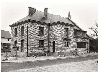
Maison de la ferme Dulin, vue depuis la rue de Haut, par Jean Hubert photographe à Amiens, 19 avril 1951 (AD Somme ; 1272 W 515). Repro. Thierry Lefébure IVR32_20248000017NUCA
