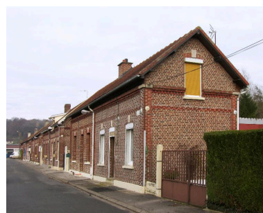
Vue d'ensemble de la cité ouvrière. Phot. Bertrand Fournier IVR22_20138016091NUC2A
