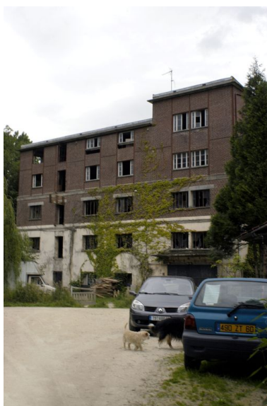
Vue d'ensemble de la minoterie.
