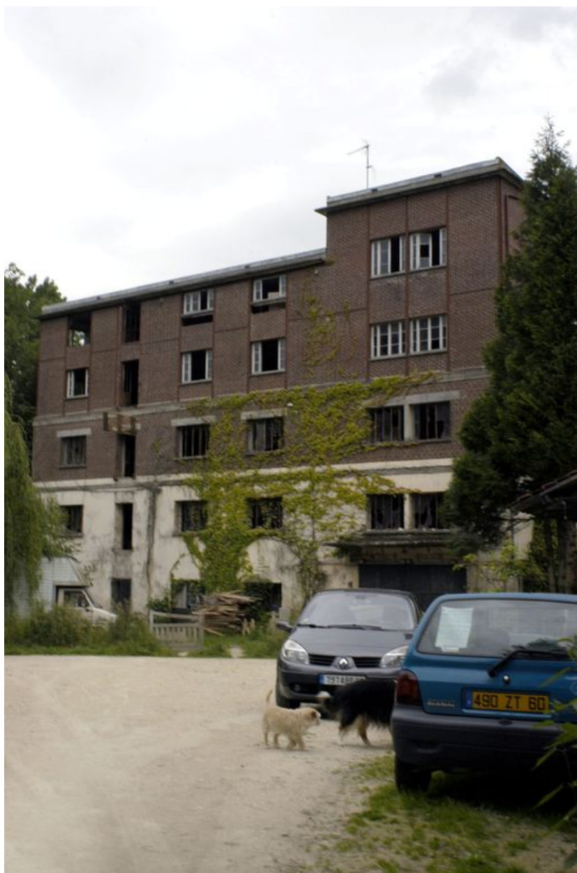
Vue d'ensemble de la minoterie.
