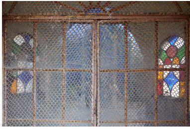
Détail de la porte grillagée et des vitraux en arrière-plan. Phot. Delphine Volto Jourdan IVR32_20245902792NUCA
