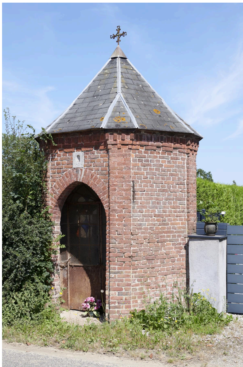
Vue rapprochée, côté droit et façade principale.
