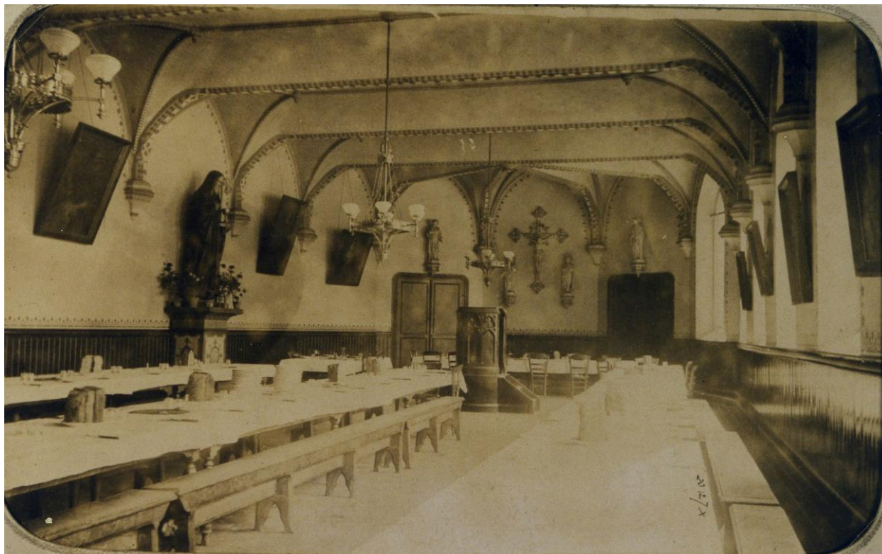
Rez-de-chaussée de la chapelle construite par Augustus Pugin, avant 1903.
