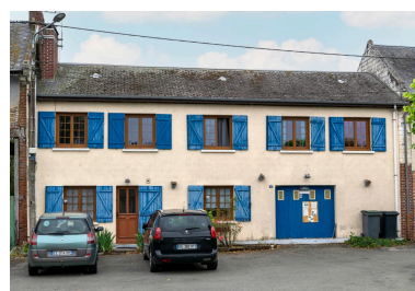
Ancien café Patte-Liger, n°48 rue Principale, vue depuis l'est. Phot. Marc Kérignard IVR32_20216000853NUCA
