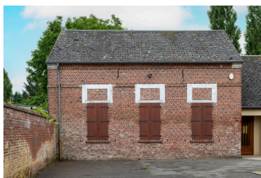
Bâtiment d'école derrière la mairie, 2e moitié 19e siècle, vue depuis l'est. Phot. Marc Kérignard IVR32_20216000855NUCA
