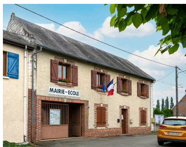
Mairie-école, vue depuis le sud-est. Phot. Marc Kérignard IVR32_20216000854NUCA
