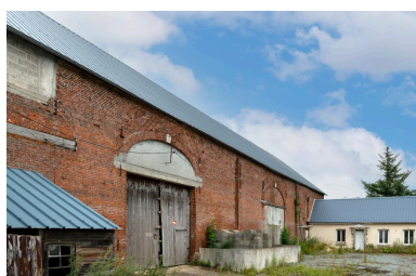
Grange ayant abrité le théâtre aux armées pendant la Première Guerre Mondiale, construite en 1853 (date portée), vue depuis le sud-ouest. Phot. Marc Kérignard IVR32_20216000845NUCA
