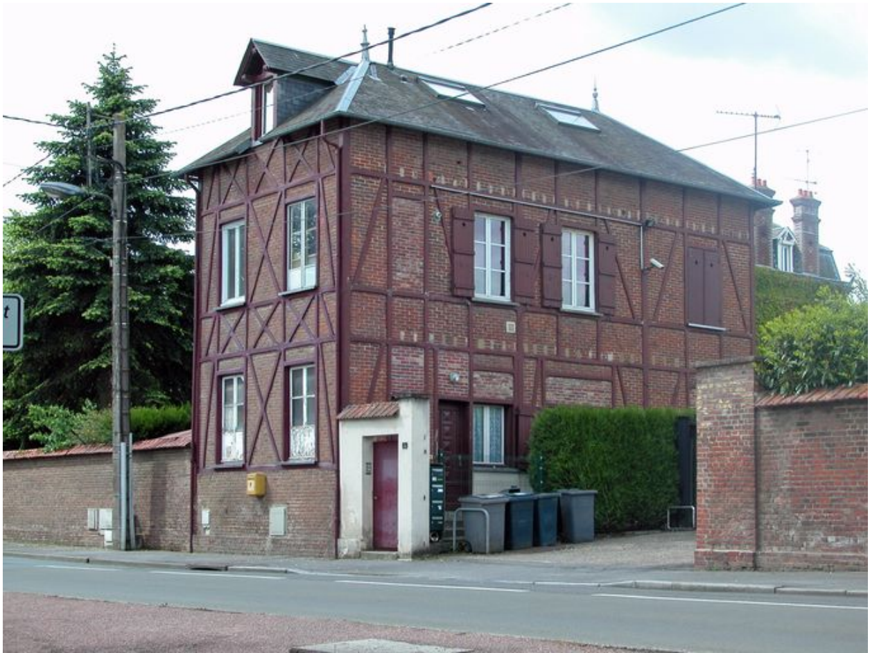
Vue latérale des bureaux.
