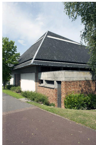
Vue extérieure du flanc droit de l'église. Phot. Pierre Thibaut IVR31_20155900351NUCA
