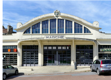
Vue de l'entrée. Phot. Thierry Lefébure IVR32_20230200185NUCA
