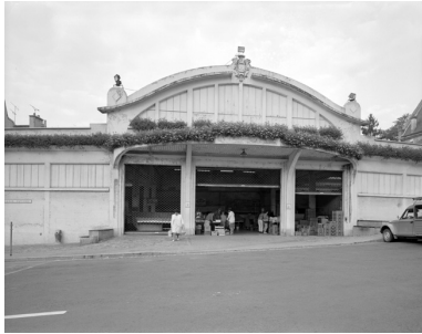
Élévation sur la place en 1990. Phot. Thierry Lefébure IVR22_19900201873V
