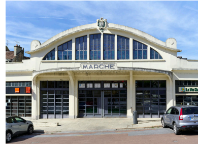
Vue de l'entrée. Phot. Thierry Lefébure IVR32_20230200185NUCA
