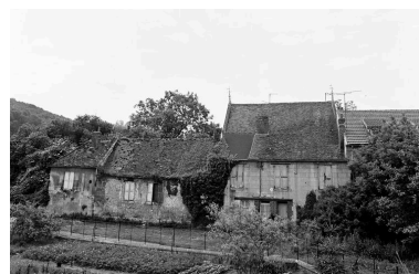
Vue générale, côté nord. Phot. Olivier Coquelle IVR22_19946001192X
