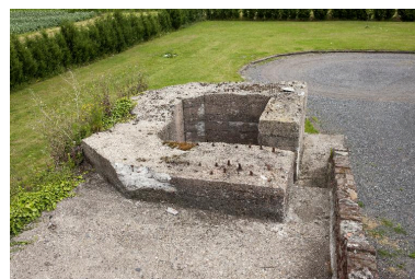
Poste d'observation depuis le couvrement de la casemate, vers le sud-ouest Phot. Jean-Marc Ramette IVR31_20145904492NUCA
