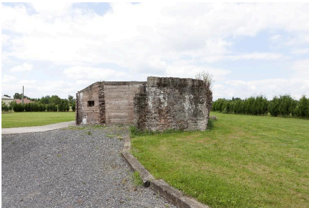
Pignon nord vers le sud-ouest
