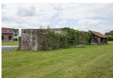
Revers de la casemate, vers le sud Phot. Jean-Marc Ramette IVR31_20145906018NUCA
