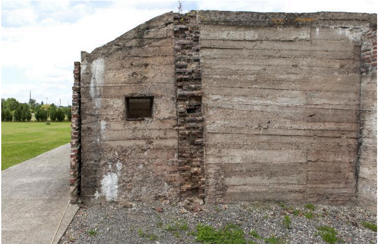
Pignon nord vers le sud-ouest. Détail
