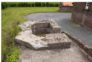
Poste d'observation depuis le couvrement de la casemate, vers le sud-ouest Phot. Jean-Marc Ramette IVR31_20145904493NUCA
