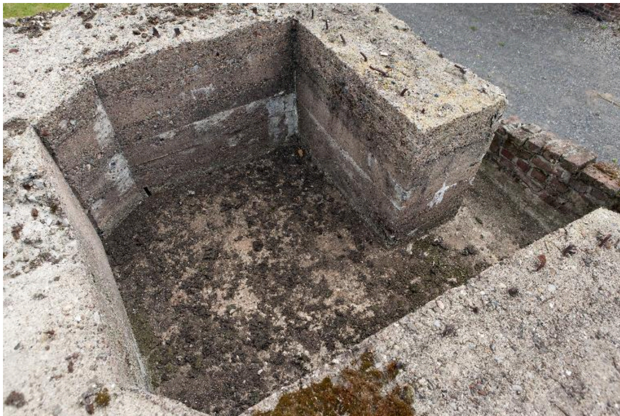
Vue en plongée sur le poste d'observation
