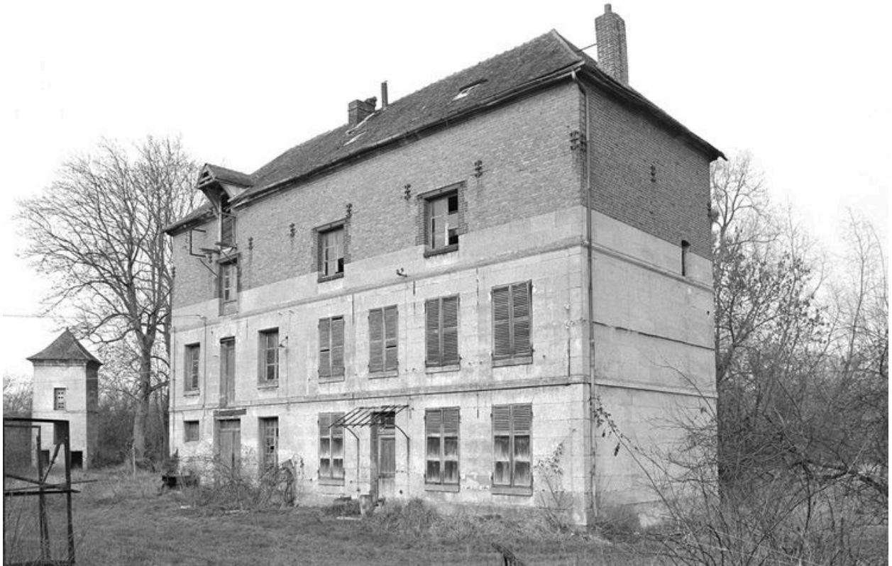
Façade antérieure du moulin.
