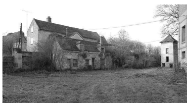
Conciergerie et logement patronal. Phot. Benoît Dufournier IVR22_19936000025Z
