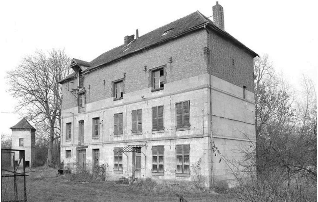
Façade antérieure du moulin.
