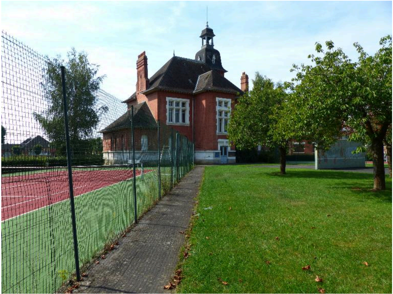
Vue de situation depuis le nord.
