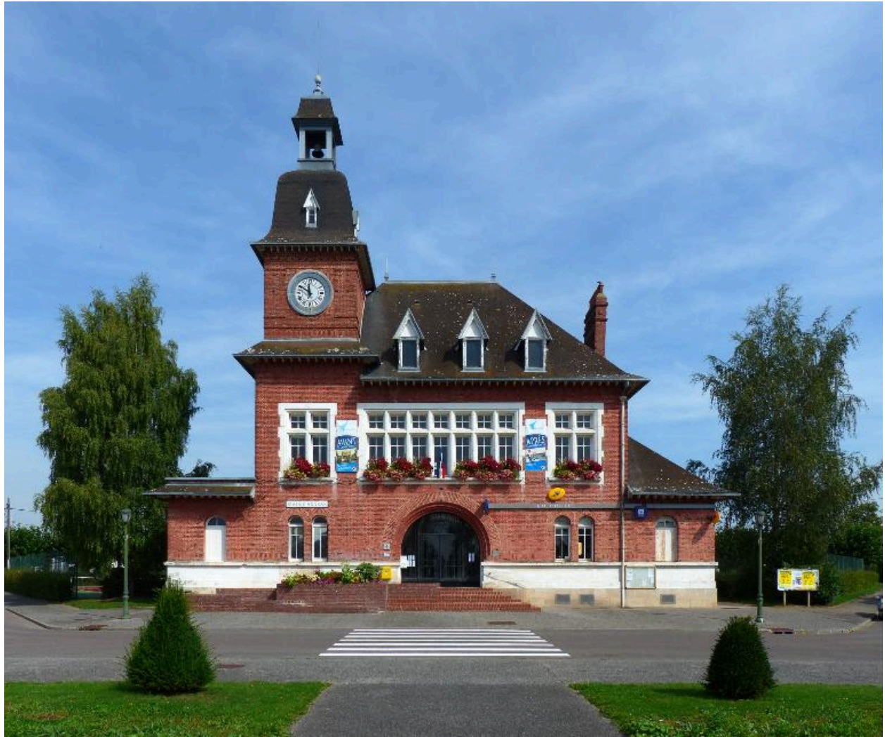
Vue générale, depuis le sud.
