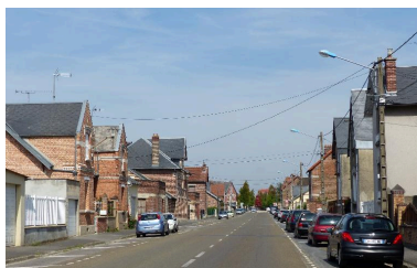
La rue Henri-Martin. Phot. Isabelle Barbedor IVR32_20170205284NUCA
