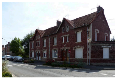
Maison à quatre unités d'habitation, 47 à 53 avenue Jean-Jaurès. Phot. Isabelle Barbedor IVR32_20170205278NUCA
