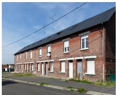
Logement d'ouvriers, rue Jules-Ferry. Phot. Isabelle Barbedor IVR32_20170205279NUCA
