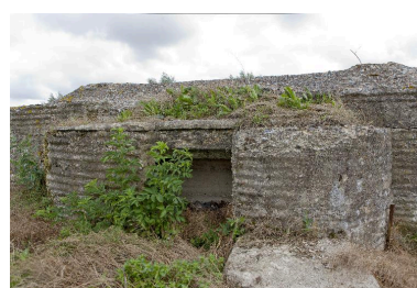
Entrée, vers le sud-est Phot. Jean-Marc Ramette IVR31_20146203025NUCA
