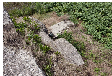
Vue de dessus du porche pare-souffle Phot. Jean-Marc Ramette IVR31_20146203031NUCA
