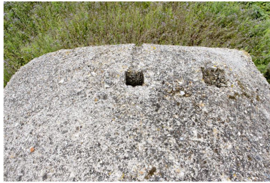
Partie sud-ouest du couverture avec aération et/ou cheminée périscopique Phot. Jean-Marc Ramette IVR31_20146203029NUCA
