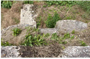
Vue de dessus du porche pare-souffle Phot. Jean-Marc Ramette IVR31_20146203032NUCA
