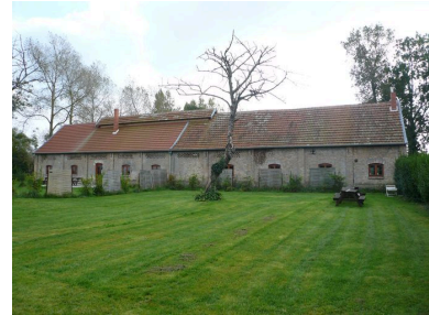
Vue de la cossetterie à l'est de la propriété. Phot. Inès Guérin IVR22_20078006239NUCA
