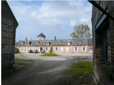
Vue du logis au nord. Phot. Inès Guérin IVR22_20078006237NUCA
