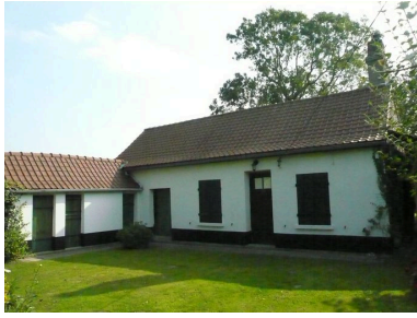
Vue générale. Phot. Inès Guérin IVR22_20058001403NUCA
