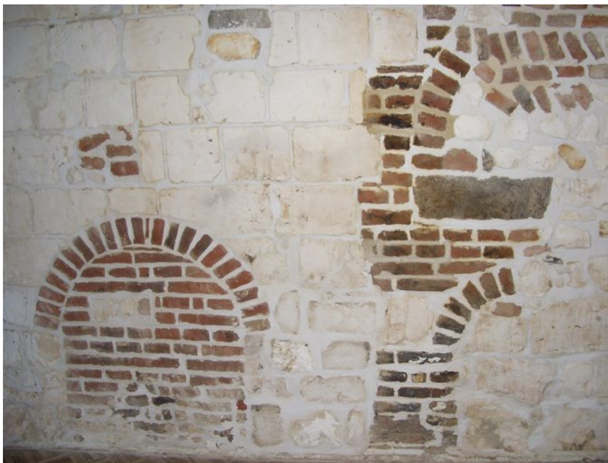
Vue des fours secondaires, aujourd'hui condamnés.
