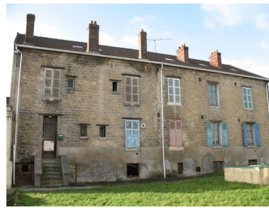
Façade antérieure des logements d'ouvriers. Phot. Clarisse Lorieux IVR22_20066005043NUCA
