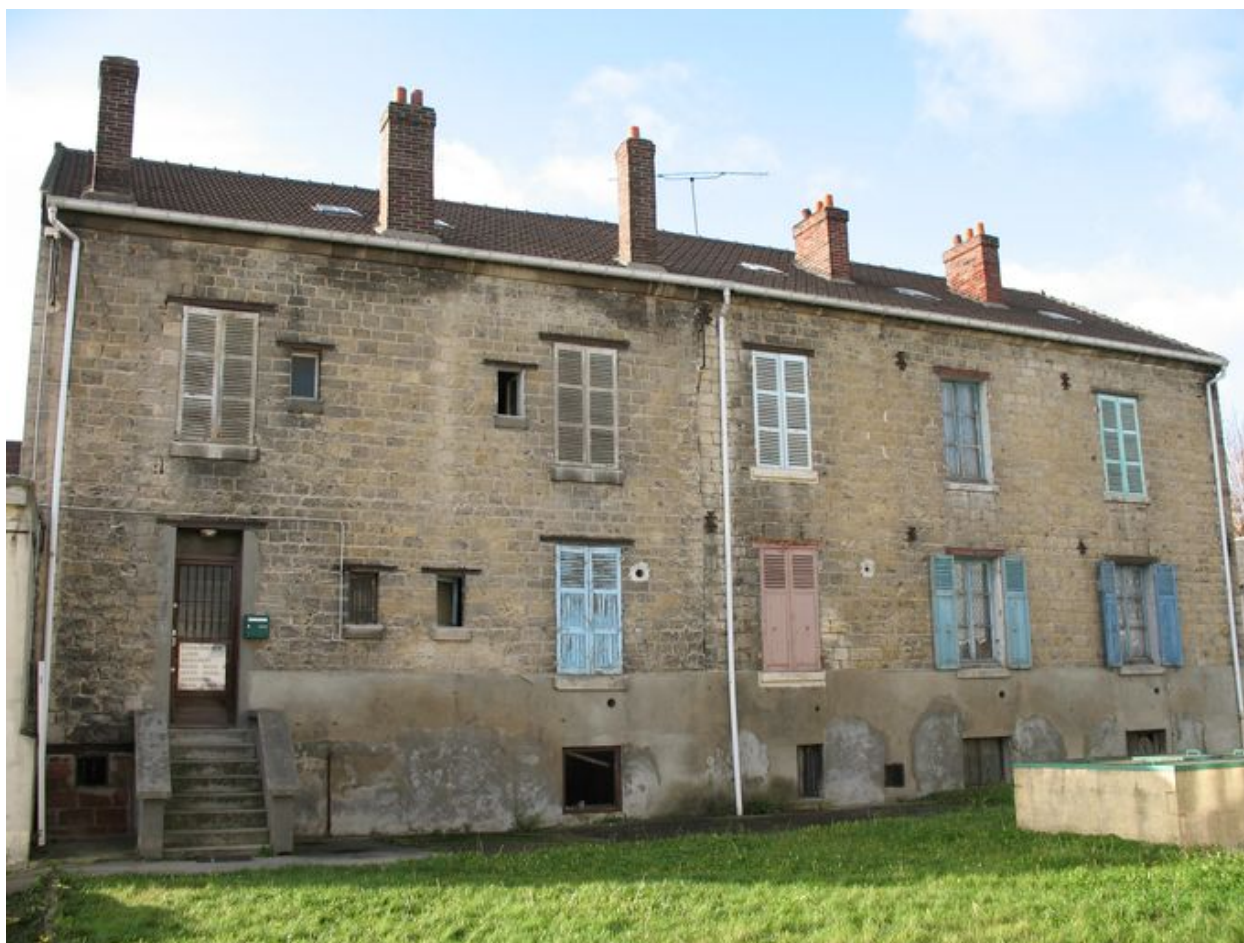
Façade antérieure des logements d'ouvriers.
