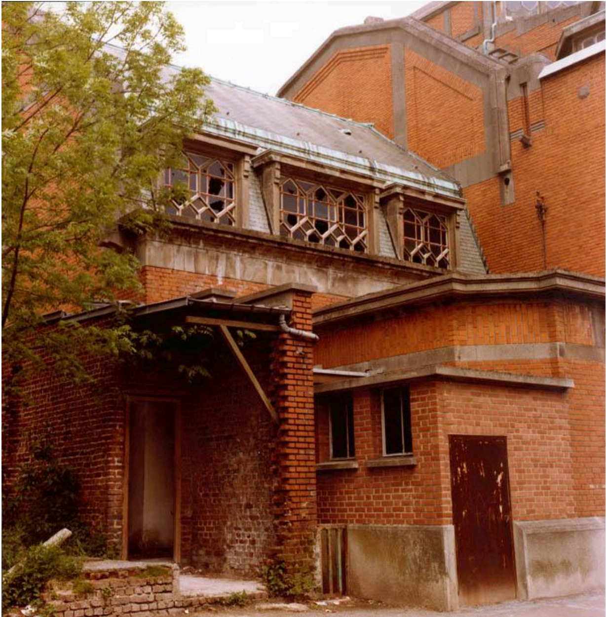
Vue partielle de trois quarts du chevet (?), avant sa destruction. Photographie, photographe inconnu, circa 1985-1986 (AC Aulnoye-Aymeries).
