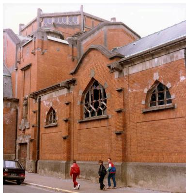
Vue partielle de l'élévation orientale et du transept, avant sa destruction. Photographie, photographe inconnu, circa 1985-1986 (AC Aulnoye-Aymeries). Repro. Stein Eddy IVR31_20015901546NUC
