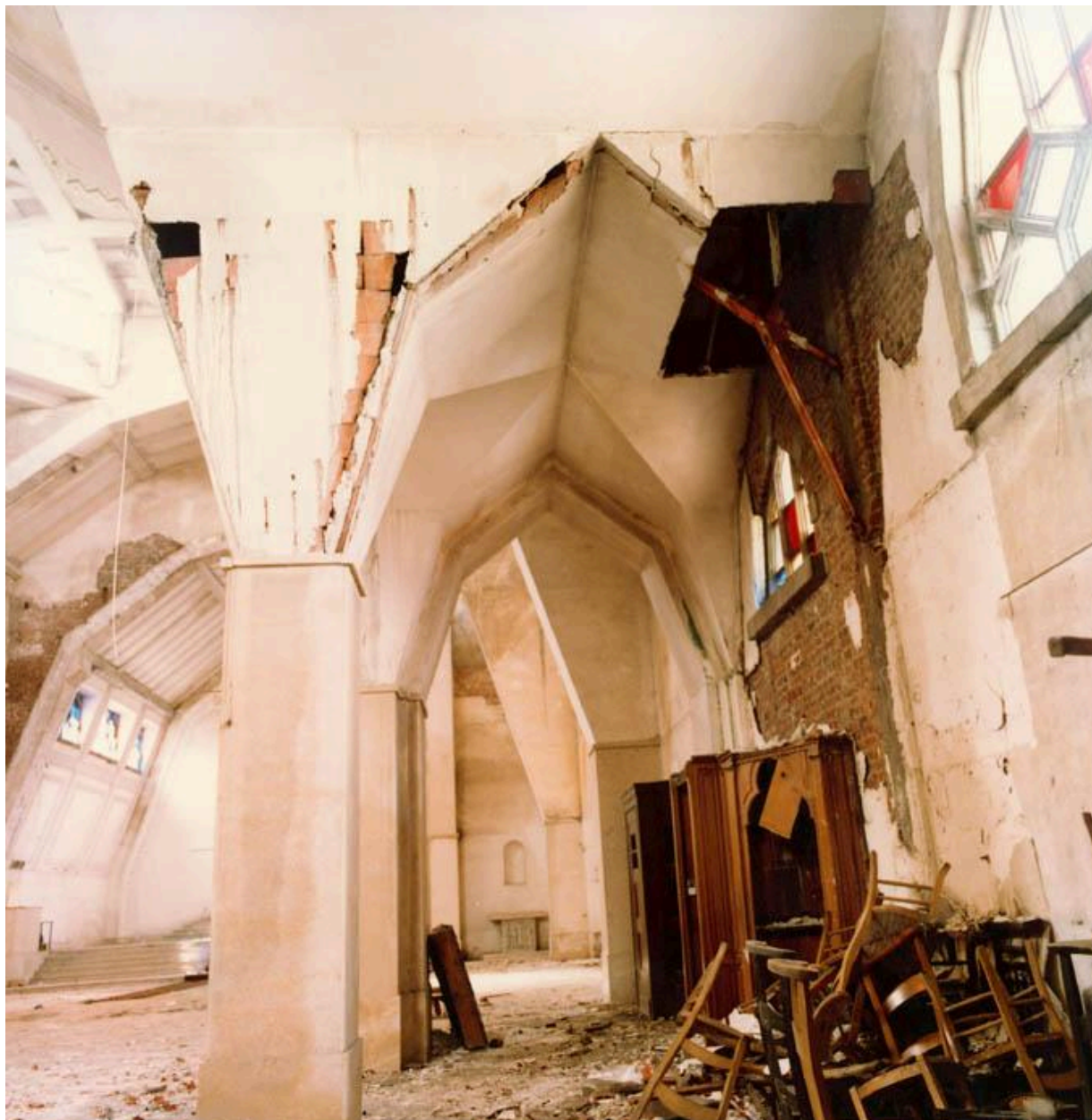
Vue intérieure, le bas côté occidental, avant sa destruction. Photographie, photographe inconnu, circa 1985-1986 (AC Aulnoye-Aymeries).
