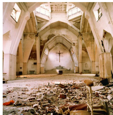
Vue générale intérieure, vers le chœur, avant sa destruction. Photographie, photographe inconnu, circa 1985-1986 (AC Aulnoye-Aymeries). Repro. Stein Eddy IVR31_20015901551NUC
