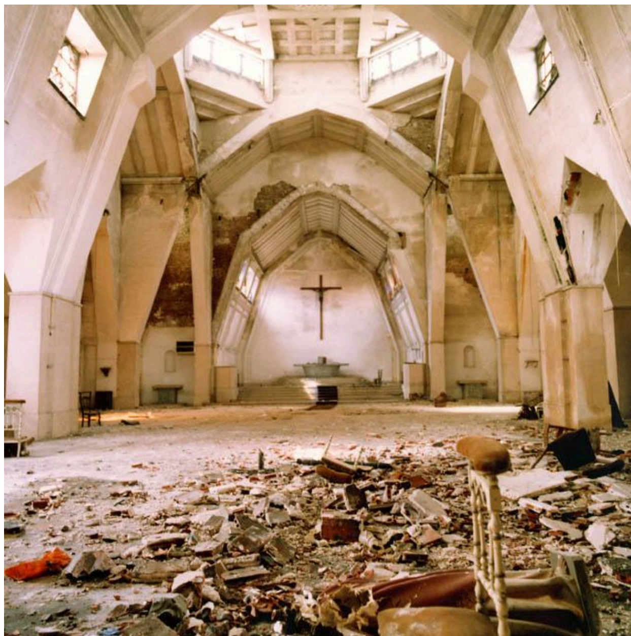
Vue générale intérieure, vers le chœur, avant sa destruction. Photographie, photographe inconnu, circa 1985-1986 (AC Aulnoye-Aymeries).
