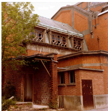
Vue partielle de trois quarts du chevet (?), avant sa destruction. Photographie, photographe inconnu, circa 1985-1986 (AC Aulnoye-Aymeries). Repro. Stein Eddy IVR31_20015901547NUC
