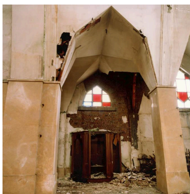
Vue intérieure, état de dégradation de la troisième travée du bas côté occidental, avant sa destruction. Photographie, photographe inconnu, circa 1985-1986 (AC Aulnoye-Aymeries). Repro. Stein Eddy IVR31_20015901549NUC
