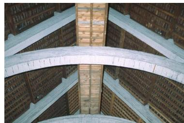
Voûte et charpente en béton.
