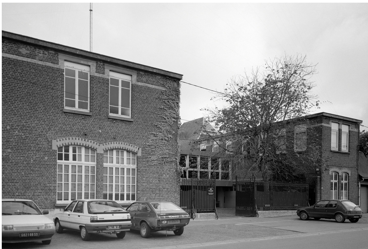
Ateliers de fabrication, élévation antérieure.
