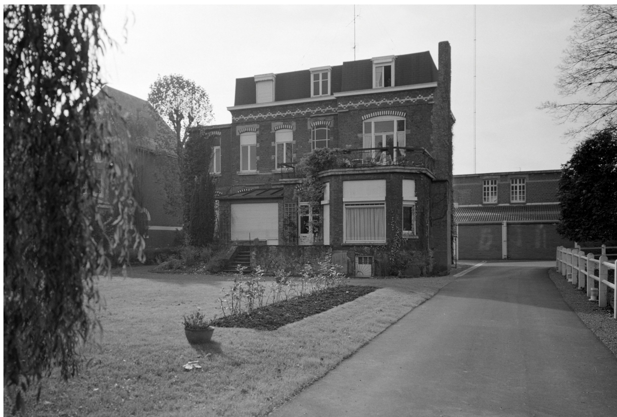
Logement patronal, élévation postérieure.
