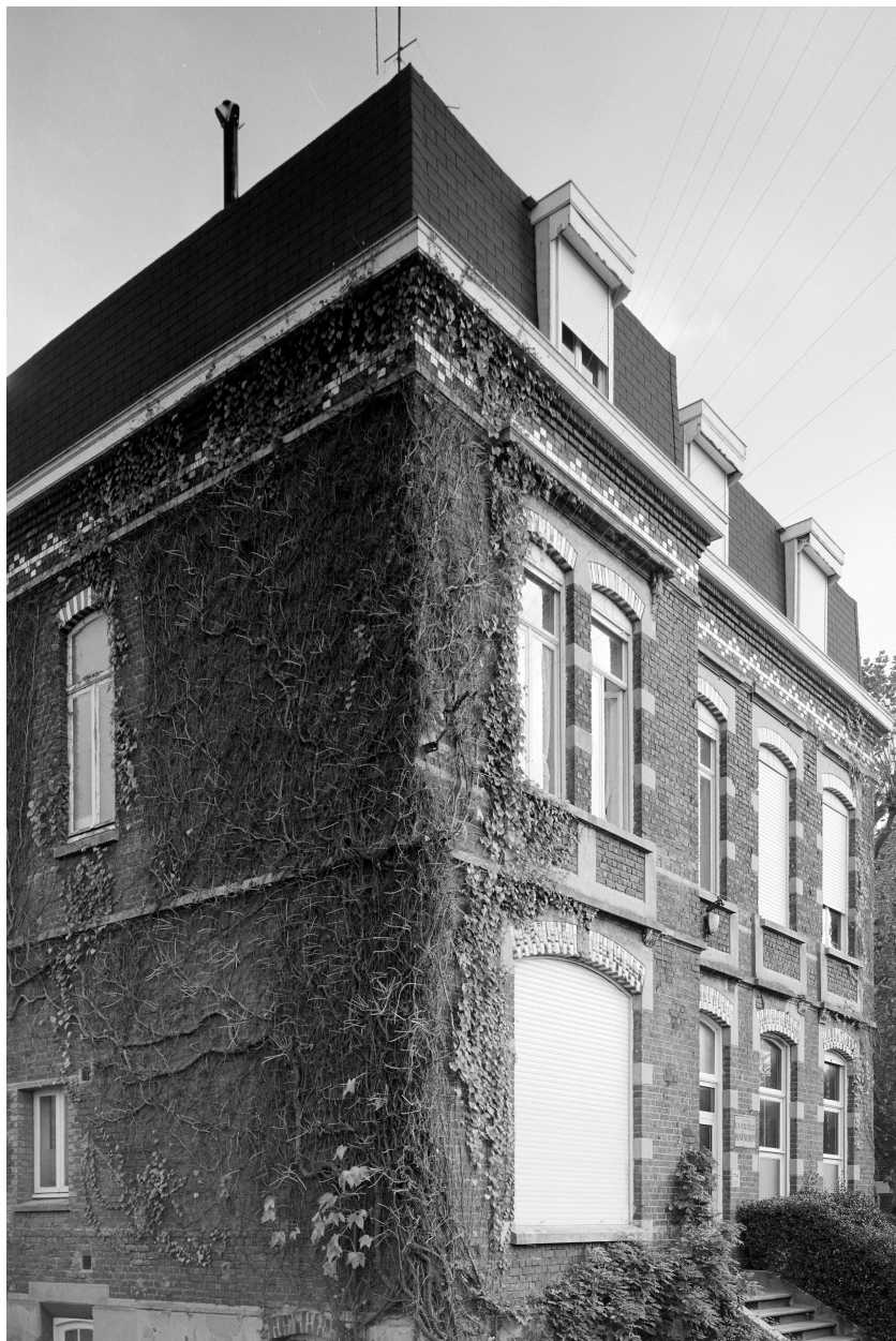
Logement patronal, élévation antérieure.
