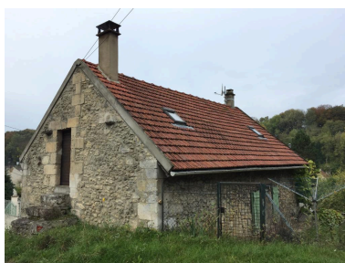
Vue du pignon sud-est ouvrant sur le chemin et de la façade nord-est ouvrant sur le jardin.
