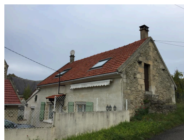
Vue de la façade sud-ouest sur cour et du pignon sud-est ouvrant sur le chemin.
