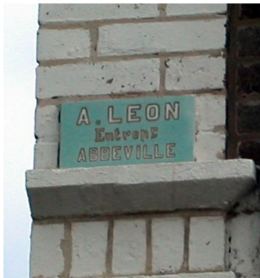
Détail du carreaux de céramique portant signature du maître d'oeuvre. Phot. Elisabeth Justome IVR22_20058003128NUCA
