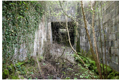
Site de lancement de V1 de Fresnoy. Vue générale d'un tunnel de stockage. Phot. Pierre Thibaut IVR31_20126201643NUCA
