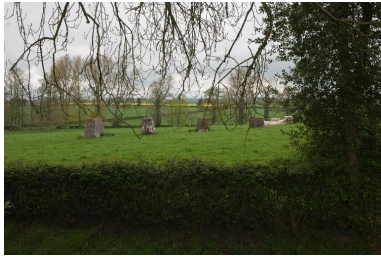
Site de lancement de V1 de Fresnoy. Plots de la rampe de lancement. Phot. Pierre Thibaut IVR31_20126201773NUCA
