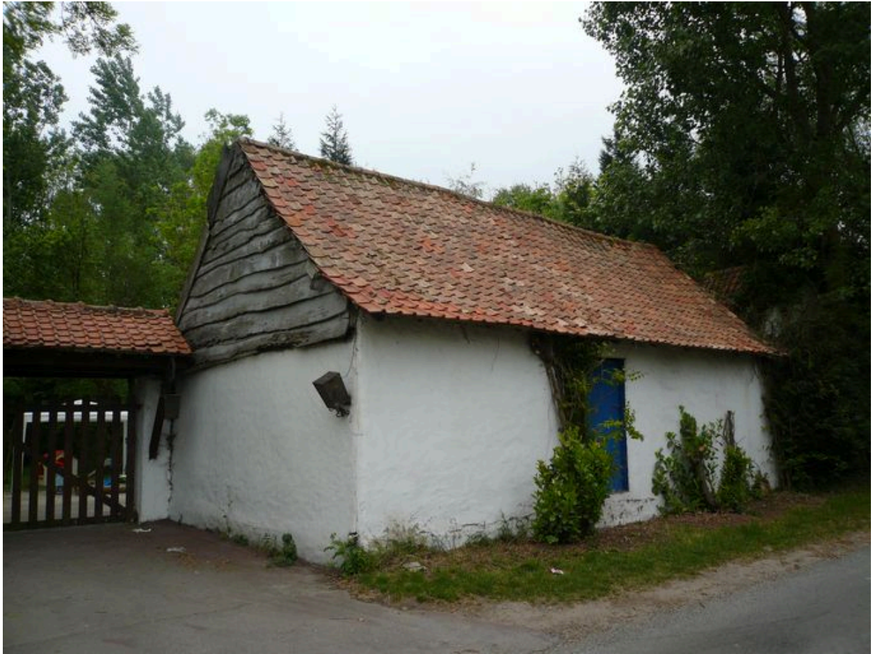
Vue des étables sur rue.
