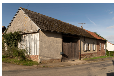
Ferme avec logis sur rue, n°26 de la Grande Rue, vue depuis l'est. Phot. Marc Kérignard IVR32_20266000021NUCA
