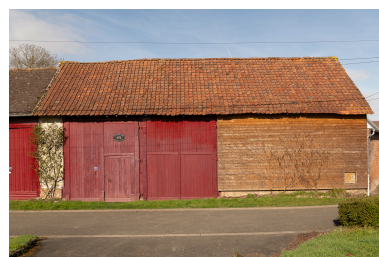
Ancienne grange sur rue, n°4 de la rue de l'Église, vue depuis le sud. Phot. Marc Kérignard IVR32_20266000022NUCA
