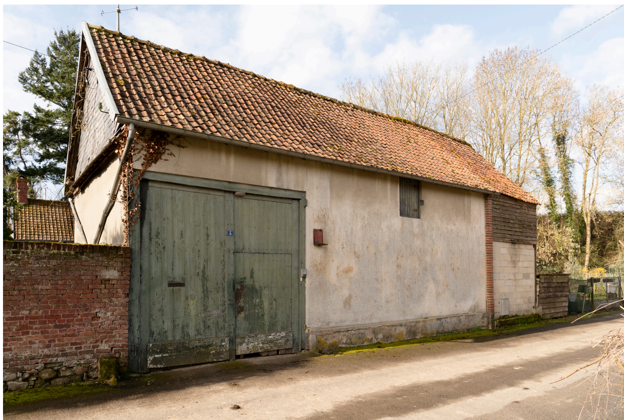
Ancienne grange avec entrée charretière, n°4 de la rue Verte, hameau de Montcru.
