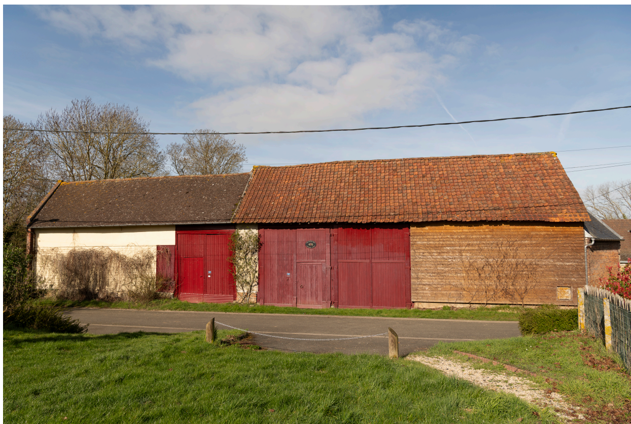
Granges alignées sur la rue, n°4 et 6 de la rue de l'Église, vue depuis l'est.
