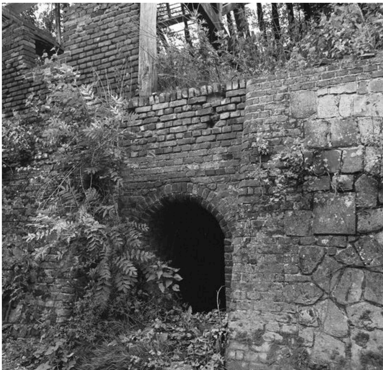
Détail d'un alandier du four Hoffmann.
