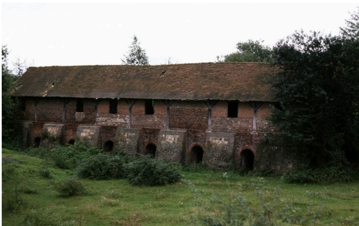
Four industriel de type Hoffmann, côté nord.
