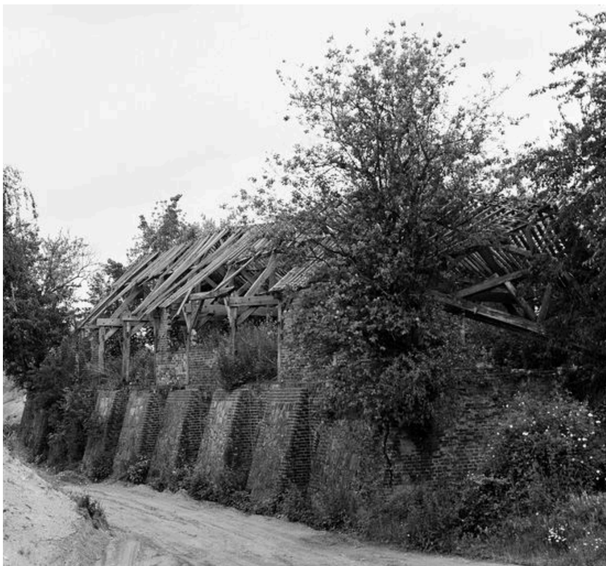
Four industriel de type Hoffmann, côté nord.
