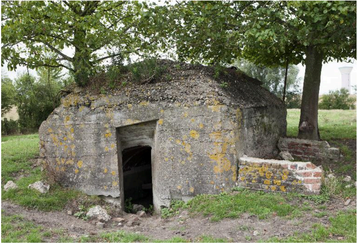
Elévation sud, entrée
