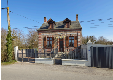
Vue de la maison, depuis la rue. Phot. Thierry Lefébure IVR32_20258000555NUCA
