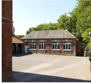
La cour et le bâtiment des classes.
