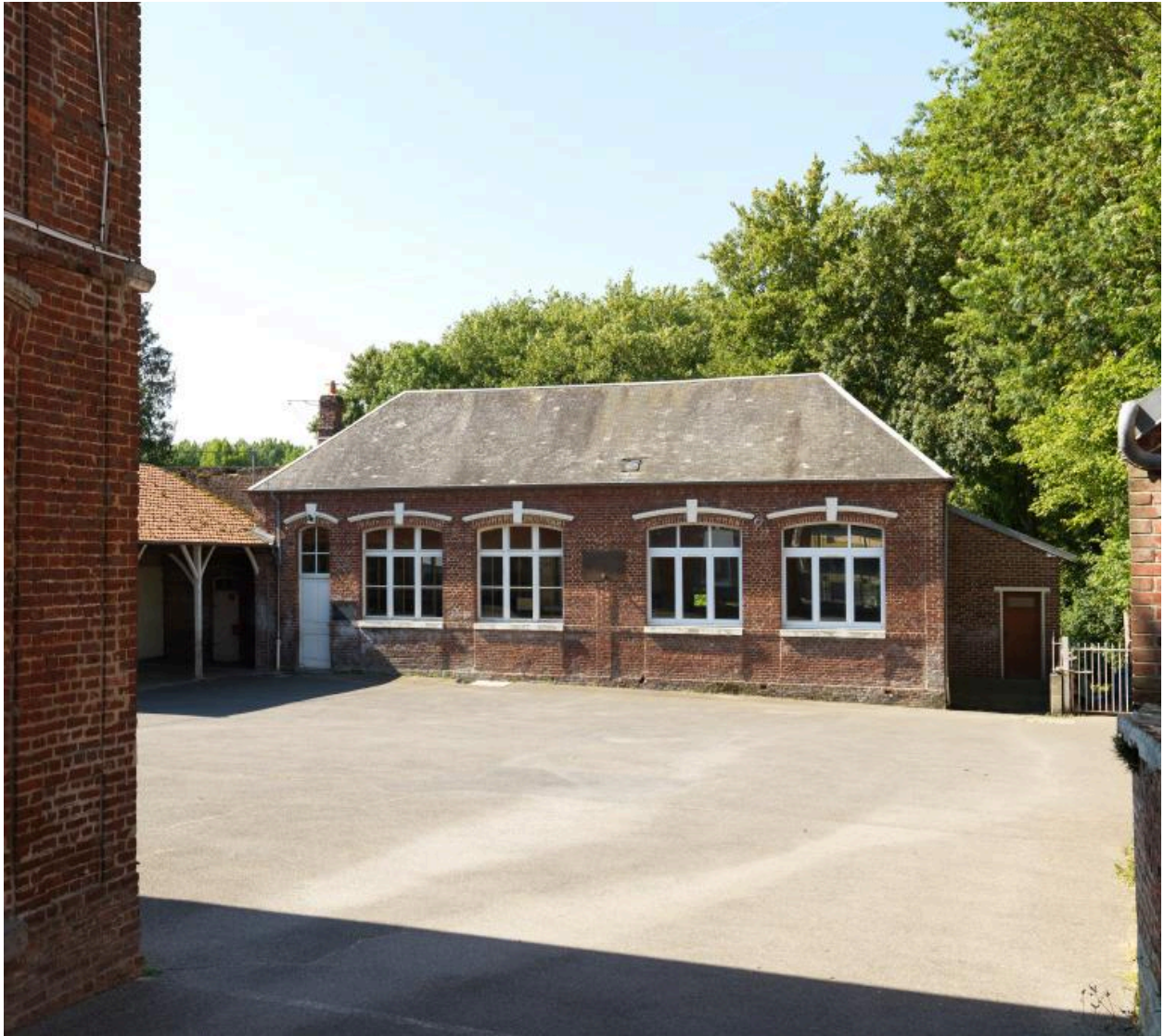
La cour et le bâtiment des classes.
