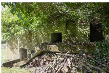
Élévation sud avec de gauche à droite, l'entrée, l'escalier menant au poste de mitrailleuse, la resserre et le poste du servent.
