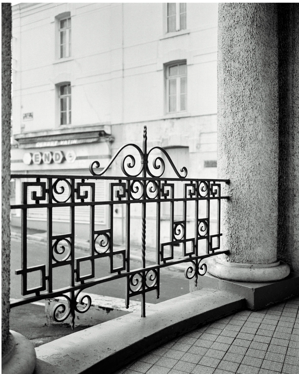
Détail de ferronnerie.
