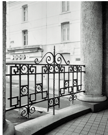
Détail de ferronnerie. Phot. Olivier Marlard IVR31_19945900338X
