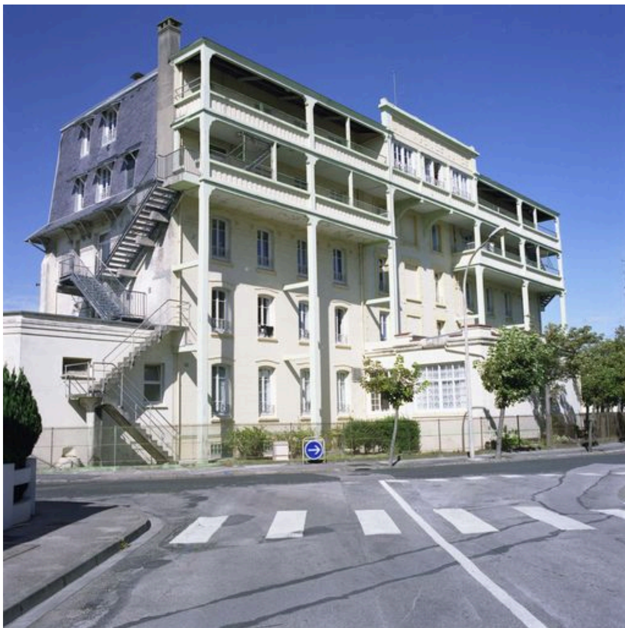
Les galeries de l'élévation postérieure.
