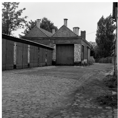
Ateliers de fabrication (?). Vue prise vers l'est. Phot. Philippe Dapvril IVR31_19885900771X
