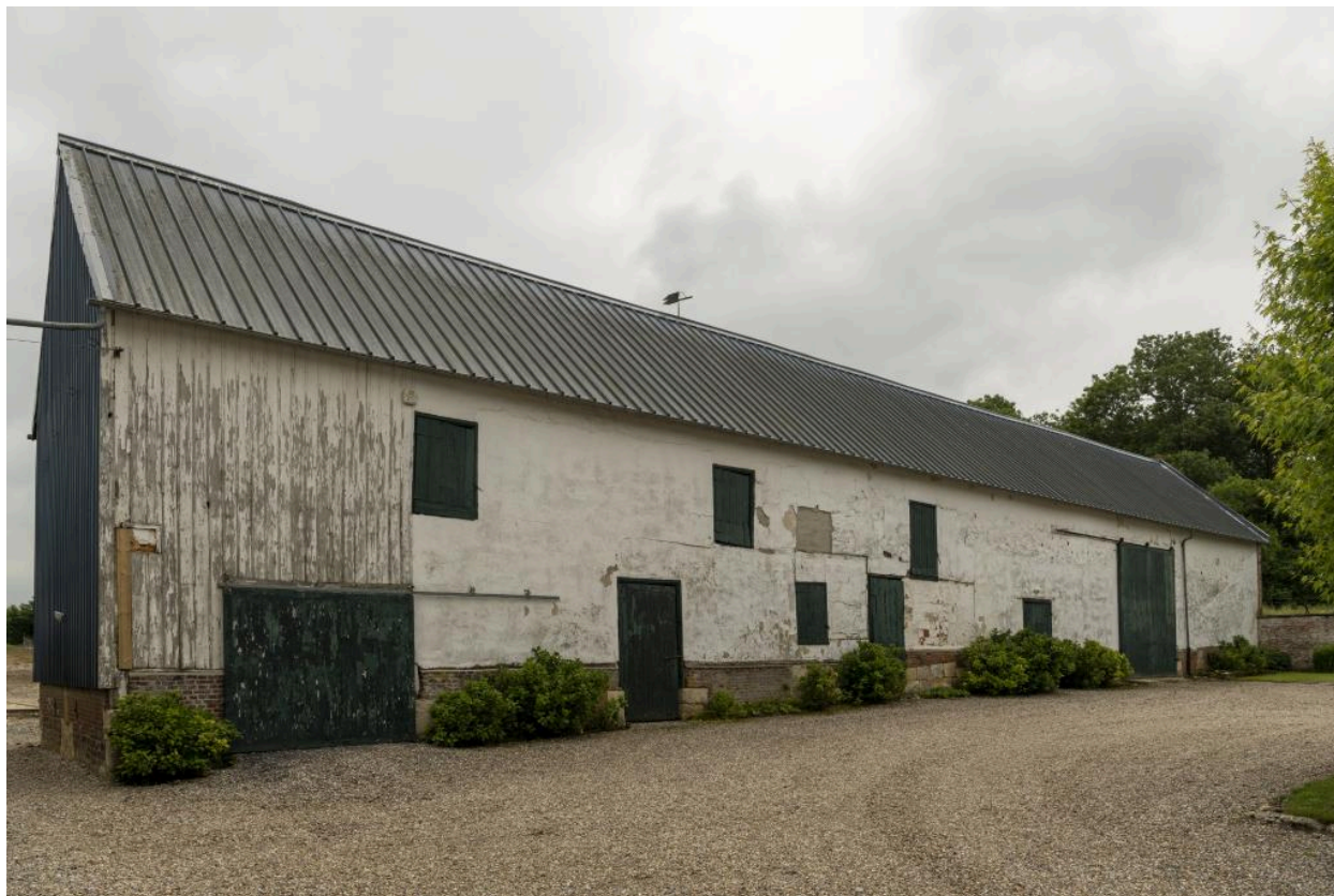
Grange, fenil et étable, en fond de cour, vue depuis le nord.
