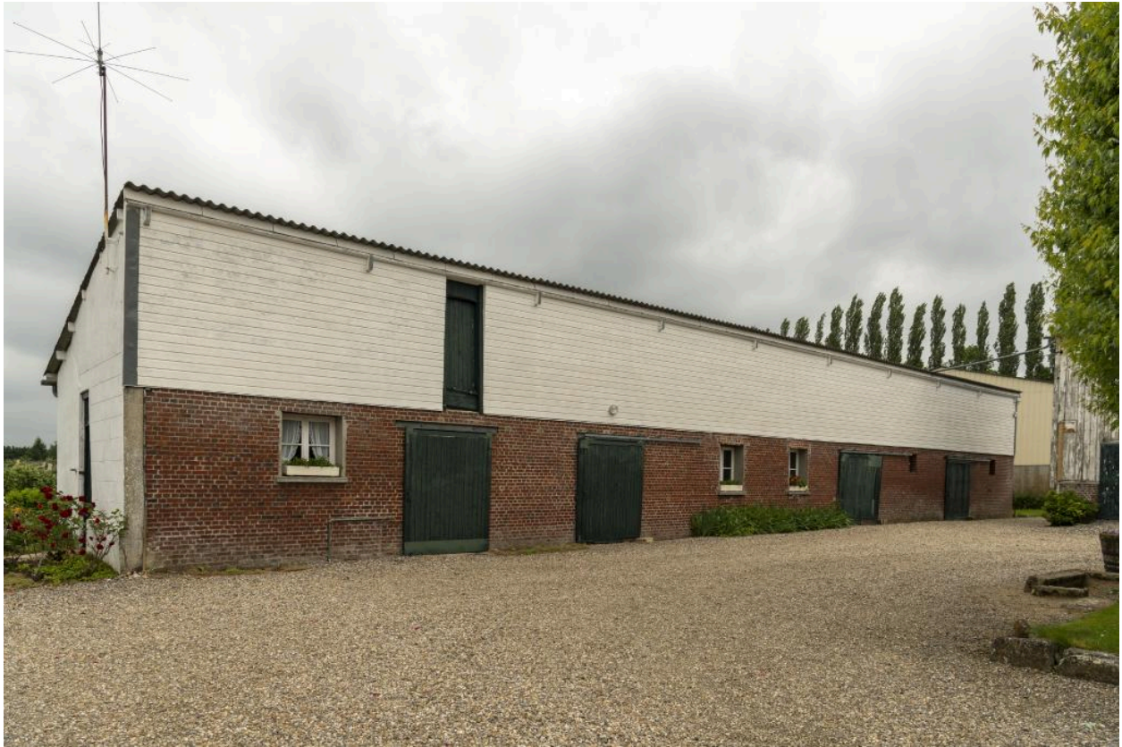
Écuries à chevaux, vue de la façade ouest depuis la cour.
