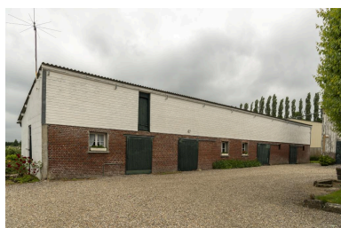
Écuries à chevaux, vue de la façade ouest depuis la cour. Phot. Marc Kérignard IVR32_20216000729NUCA
