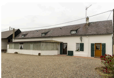
Logis avec véranda, vue de la façade sud depuis la cour. Phot. Marc Kérignard IVR32_20216000728NUCA
