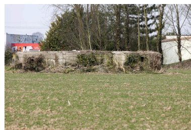
Ouvrage en U Phot. Jean-Marc Ramette IVR31_20135901174NUCA
