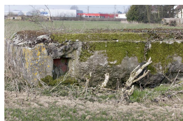
Détail de l'ouvrage en L précédent. Cette niche était-elle destinée à accueillir des munitions ? Phot. Jean-Marc Ramette IVR31_20135901177NUCA
