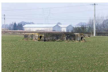
Le même, vu vers le nord-ouest IVR31_20135901167NUCA
