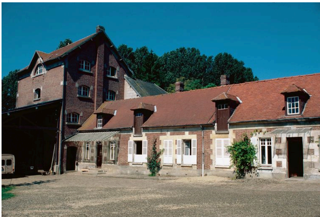
Logis du moulin, depuis la cour.
