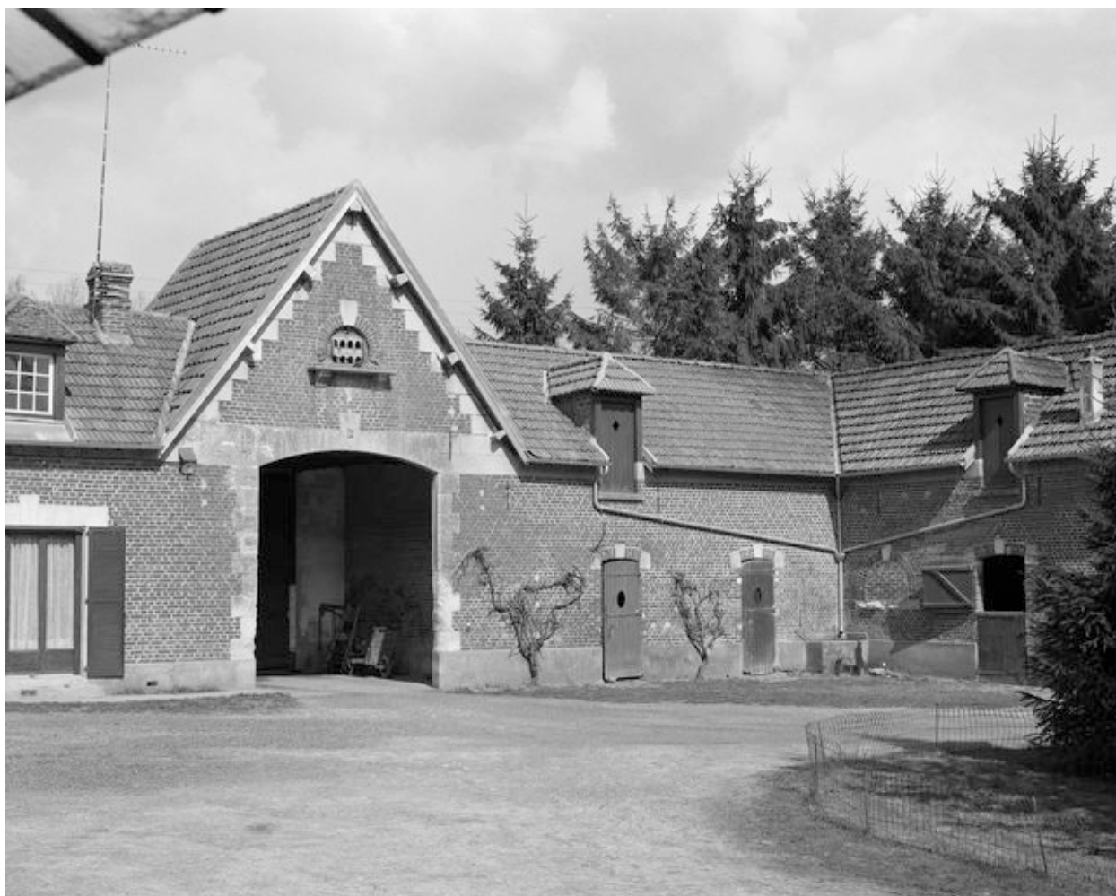
Portail, pigeonnier et écuries, depuis la cour.
