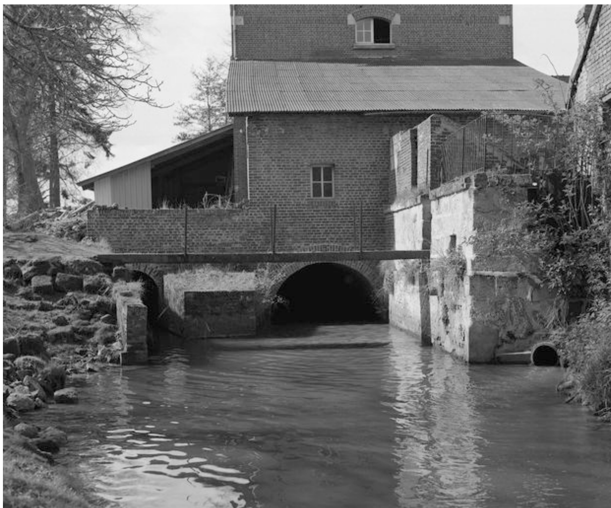
Cage du moulin. Elévation latérale.
